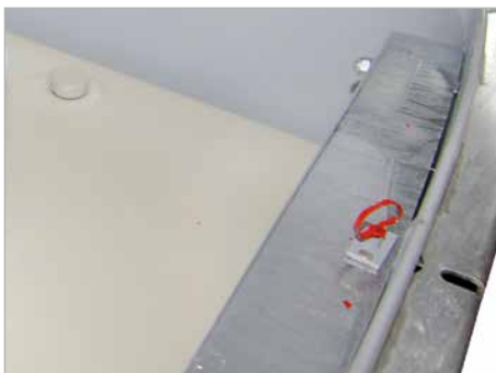
Peilstab für Leckagekontrolle
