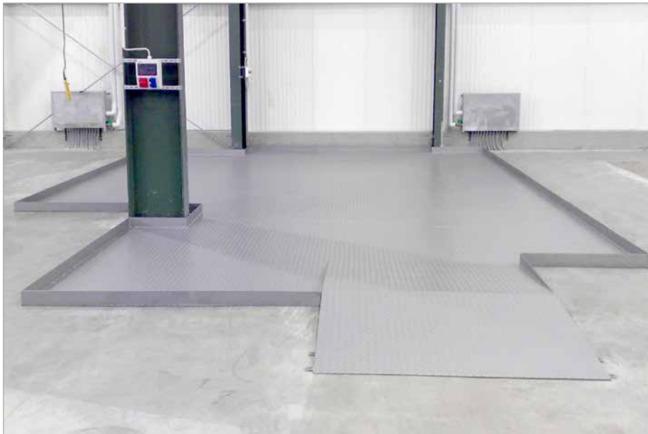
Bodenschutz-Auskleidung mit Aussparung für Pfeiler und Überfahrrampe
