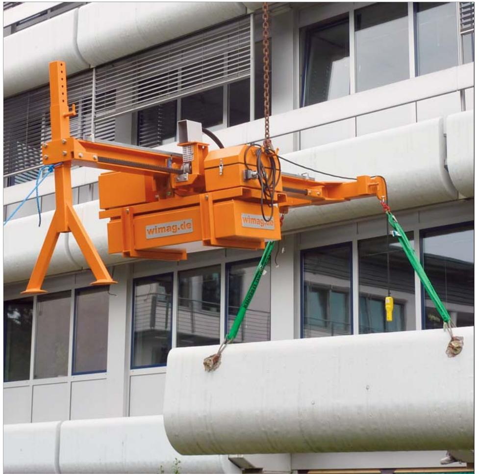
WIMAG Ausgleichstraverse AGT mit hydraulisch verfahrbarem Gegengewicht bei der Demontage von Betonelementen, da diese wegen des Dachüberstandes nicht direkt angeschlagen werden können.
