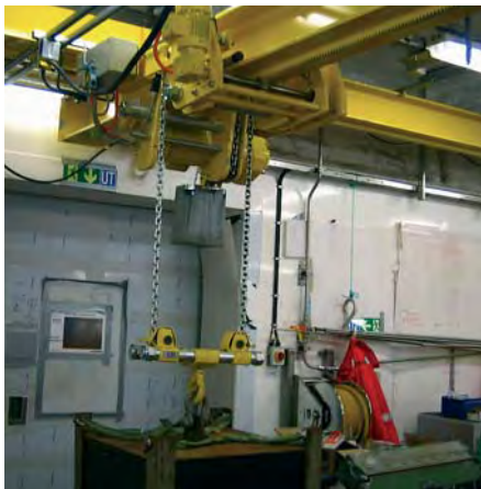
Einträger-Decken-Handlaufkran Typ EDHH mit Stirnradflaschenzug Figur 29/98 HH Zahnstangenantrieb Tragfähigkeit: 3 T
