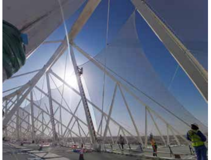
Windreduktionsnetze für die Fußballweltmeisterschaft in Katar
