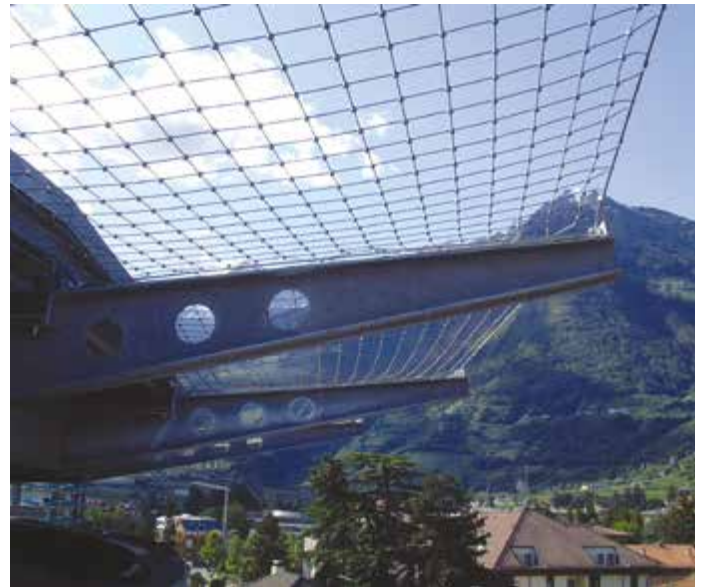
Dralo® als Außensicherung für einen Hubschrauberlandeplatz auf einem Krankenhaus in Meran.
