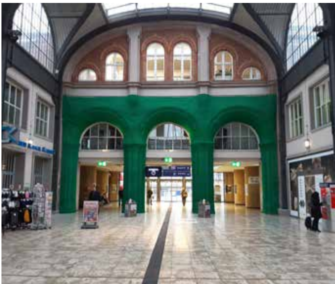
Fassadensicherungsnetz im Bahnhofgebäude Kassel
