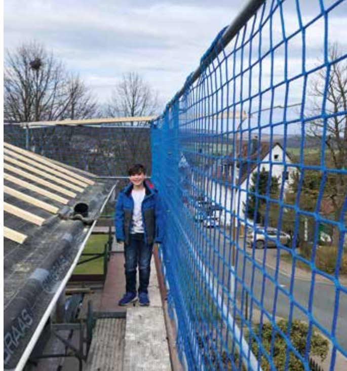
Das Gerüstrohr ist Masche für Masche durch das Netz gezogen.
