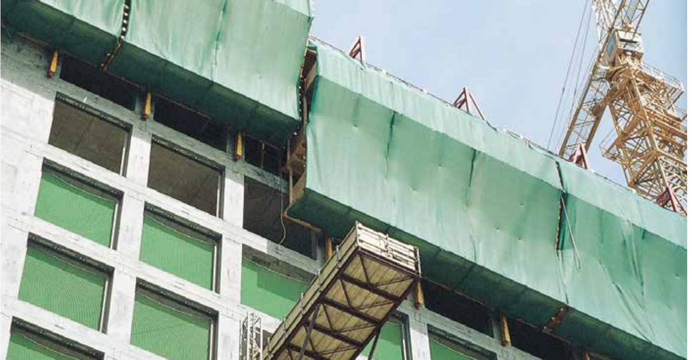
Seitenschutzabsicherung mit engmaschigen Seitenschutznetzen und luftdurchlässigem PE-Gewirke (200g/m 2 ) beim Bau des Japan-Centers in Frankfurt. ①
