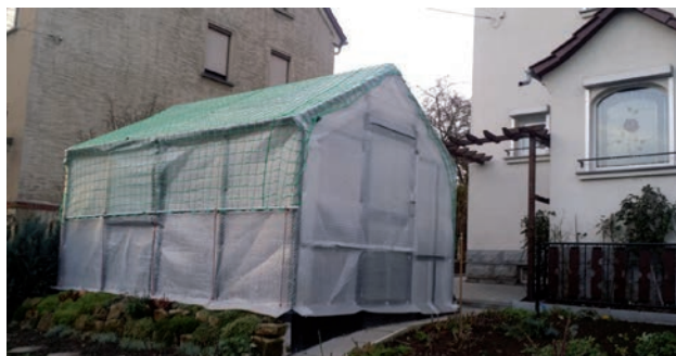
Dachsicherung am Gewächshaus
