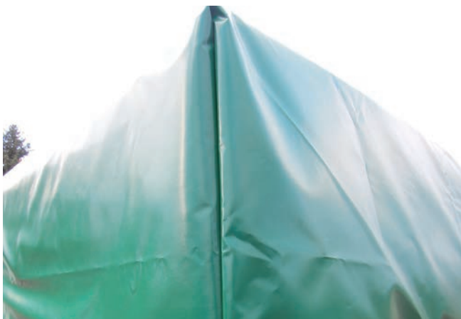
nach innen geschlagene und vernähte Ecken im Detail
