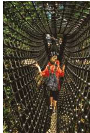
Netztunnel , dreieckig, Laufbelag aus PP-Laufseil
