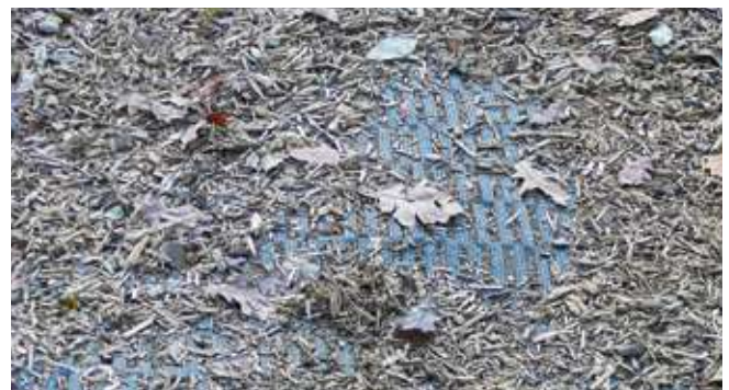
Rasenschutzmatte in eingebautem Zustand (für Foto freigelegt)
