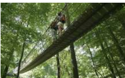
Holzlaufsteg-Brücke, Länge 40 m
