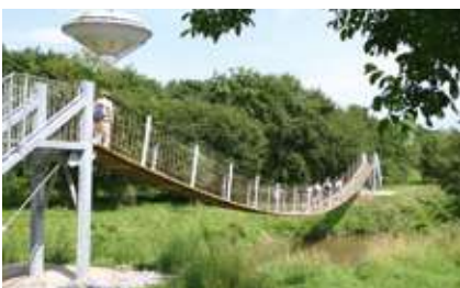
Holzlaufsteg-Brücke, Länge 54 m
