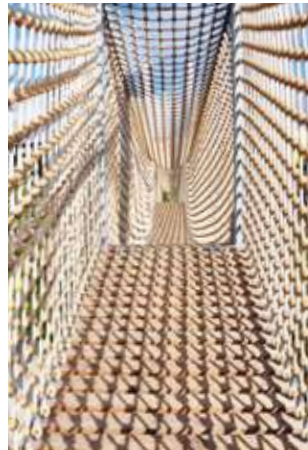
Netztunnel , viereckig, Laufbelag aus Lärchenholz-Sprossen
