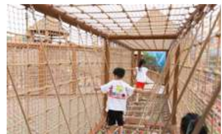
Netztunnel mit abgehängten Laufspinnen, Länge 8 m
