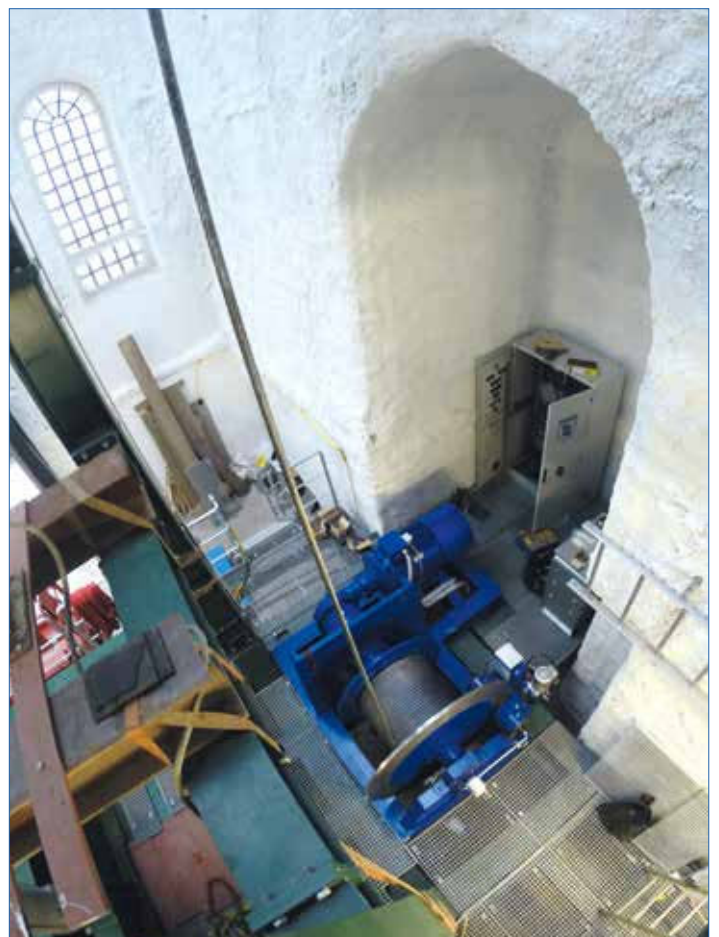
SB-E 316 als Hubwinde für Pumpenstrang
