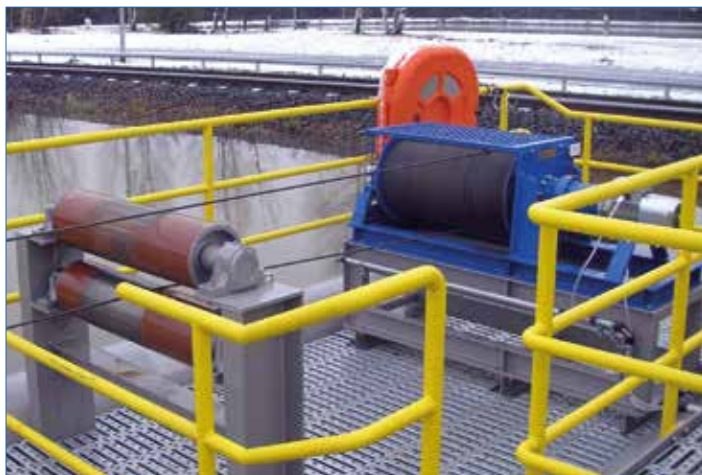
SB-E 304 als Traversierwinde für Wasseraufbereitungsanlage
